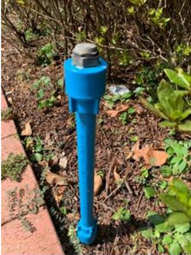
圖一、地上部分連接噴嘴之水管應採用高密度聚乙烯喉管或具同等質量之軟膠喉管，每隔 3 米安裝一個可調校 180 度銅噴嘴，膠喉一般高出泥面 30 公分。
