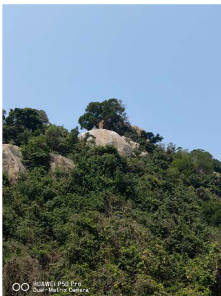
氹仔信安馬路近華藝工業大廈山坡懸石 -竣工圖片
