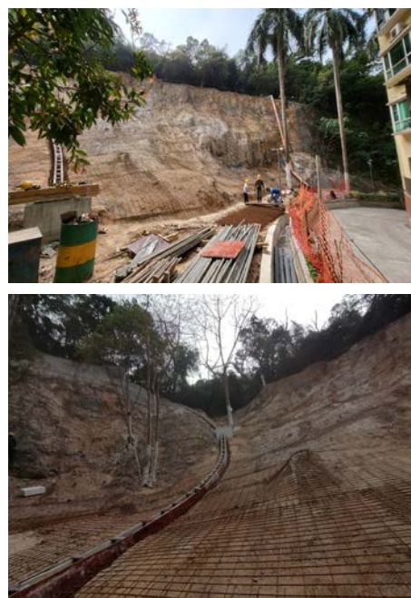
氹仔嘉樂庇總督馬路茵景園後側 -施工圖片
