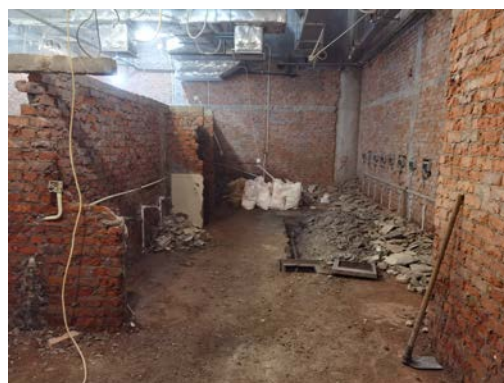
T18 氹仔客運碼頭公廁改善工程 -施工圖片
